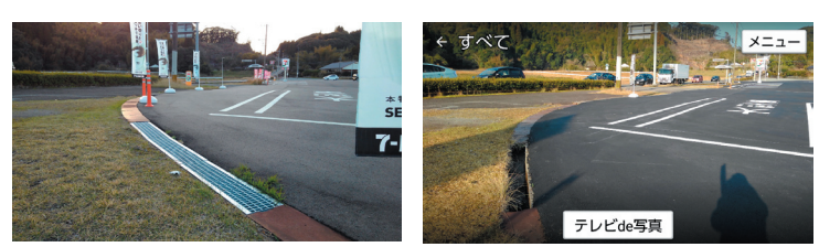
工事後 工事前 セブンイレブン樋脇店前
