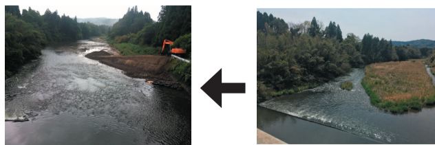
(写真) 樋脇川寺下橋から見た土砂 右 撤去前 左 撤去後
